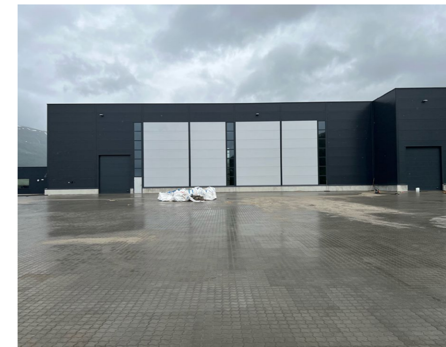
NYTT: I 2022 sto det nye sorteringsanlegget på Bjerkvik ferdig.
